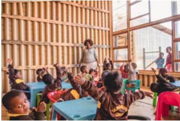
Le mur Sud est constitué d'une structure en palettes sur laquelle un enduit en ciment / carton a été appliqué par Joubert Loots
