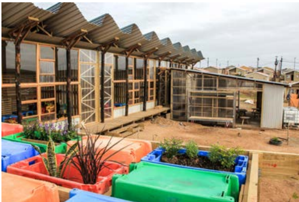
La façade Nord consiste en un mur rideau qui s'ouvre largement sur le paysage environnant par Gorka Biurrun
