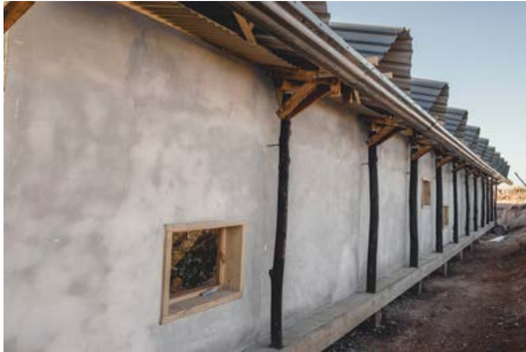
Le mur Sud est constitué d'une structure en palettes sur laquelle un enduit en ciment / carton a été appliqué par Joubert Loots
