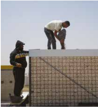
Pouya Khazaeli, RE:BUILD, Jordanie (2015) Les modules du projet RE:BUILD mesurent 7 x 7 mètres. Leurs murs périphériques, composés de deux parois séparées par une lame d'air isolant naturellement l'habacle, sont recouverts d'un enduit composé d'aggrégats propres au site. The modules of RE:BUILD measure 7x7 meters. Their double exterior walls are separated by an air gap for natural insulation and plastered with local aggregates.
