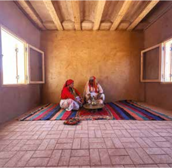
Dans le même esprit que Salima Naji, l'architecte marocaine Aziza Chaouni a récemment créé un prototype de logement parasismique près du village de Taalat N'Yacoub, gravement touché par le tremblement de terre de 2023. Le bâtiment associe des briques de terre compressée sans mortier (composées à 95% de terre et à 5% de ciment Durabric, elles présentent une excellente résistance sismique), une charpente en bois de cèdre et une toiture en terre compactée ; les habitant-es ont participé à la conception comme à la construction. En plus d'être peu onéreux, le prototype a été construit en deux mois ; il sera répliqué pour former un village comptant des maisons et infrastructures partagées. Along similar lines to Salima Naji, Moroccan architect Aziza Chaouni recently developed a prototype for seismic-resilient housing near the village of Talat N'Yaaqoub, which was severely affected by the 2023 earthquake. The house is made of compressed earth bricks without mortar (composed of 95% earth and 5% Durabric cement mix, making it highly resistant to earthquakes), a cedarwood frame, and a compacted clay roof. Future residents were closely involved in its design and construction. In addition to being inexpensive, the prototype was built in two months and will now be used to create a village with houses and shared facilities.
