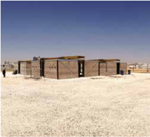
Pouya Khazaeli, RE:BUILD, Jordanie (2015) Les modules du projet RE:BUILD mesurent 7 x 7 mètres. Leurs murs périphériques, composés de deux parois séparées par une lame d'air isolant naturellement l'habacle, sont recouverts d'un enduit composé d'aggrégats propres au site. The modules of RE:BUILD measure 7x7 meters. Their double exterior walls are separated by an air gap for natural insulation and plastered with local aggregates.
