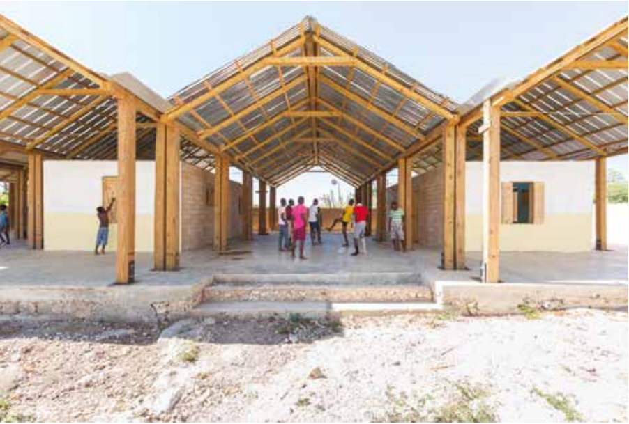
Bonaventura Visconti di Modrone, orphelinat parasismique, Haïti (2016) L’orphelinat est érigé sur une dalle de béton armé, nécessaire dans cette région particulièrement sujette aux séismes. Adapté au climat tropical humide d’Haïti, le bâtiment présente de grandes toitures ventilées. Tout en supportant des panneaux solaires, elles qualifient la nature des espaces plus ou moins privés qu’elles surplombent. In this earthquake-prone region, the orphanage is built on a reinforced concrete slab. Designed for Haiti’s humid tropical climate, its large, ventilated roof surfaces are covered with solar panels ; they create shaded spaces, some private, where children can be with their peers or spend time alone.
