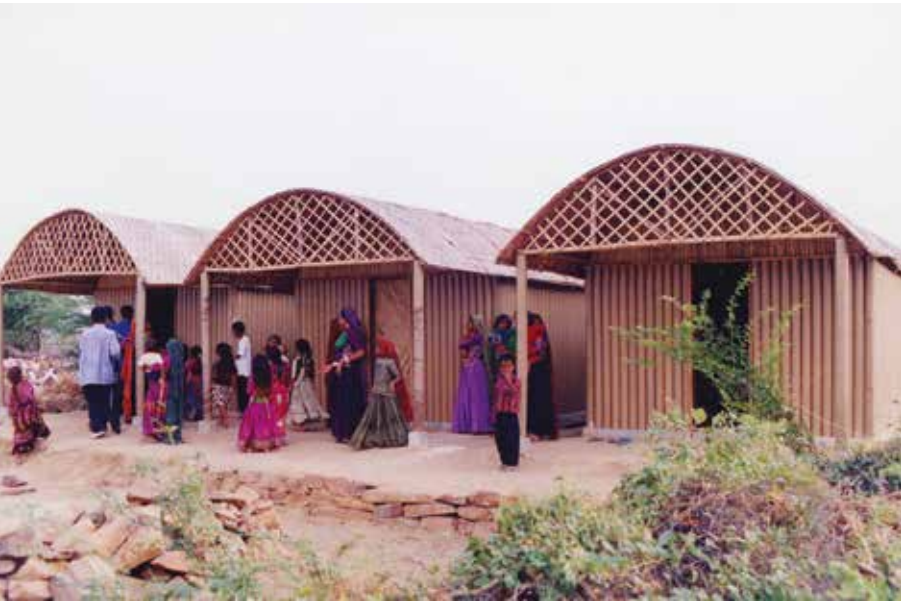
Shigeru Ban, Paper Tube Structures, Rwanda (1999), Inde (2001). En 1999, les structures de papier sont livrées sur le camp de réfugiés Tutsis de Byumba accompagnées de modes d’emploi didactiques ; les tubes de carton forment les profilés structurels des tentes. En 2001, la Paper Log House est reproduite après le tremblement de terre de Gujarat, au nord-ouest de l’Inde. Sa charpente en bambou est recouverte de nattes végétales tressées et de bâches en plastique. In 1999, the paper structures were dispatched to the Byumba Tutsi refugee camp in Rwanda. Used as structural support for emergency tents, these tubes came with easy-to-understand instructions. In 2001, the Paper Log House was adapted to the needs of earthquake victims in Gujarat, northwest India, with a vaulted bamboo framework covered in woven bamboo mats and plastic sheeting.
