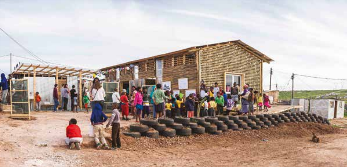
Collectif SAGA, Joe Slovo Township, Afrique du Sud (2015-2020) Très présents dans les architectures spontanées, les matériaux récupérés et réemployés sont au cœur des projets de SAGA. En atteste la crèche de Joe Slovo, avec sa structure en bois de palettes et de poteaux téléphoniques, sa porte mobile coulissant sur des roulettes de skateboard et sa façade principale, dont le « vitrail » est composé de panneaux de contreplaqué ponctués de plus de 1500 bouteilles. Like much spontaneous architecture, SAGA's designs mostly use recovered, recycled, and repurposed materials. Their preschool building has a frame of wooden pallets and telephone poles, a sliding door mounted on skateboard wheels, and a unique main facade of plywood panels studded with over 1,500 glass bottles.
